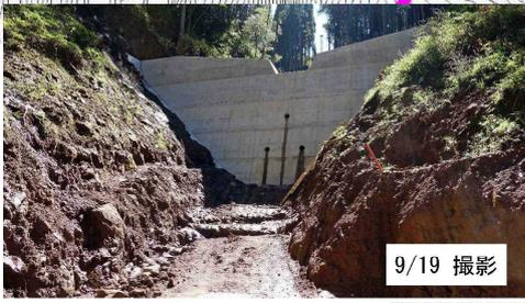
岩滝建設による高さ10mの大きな谷止めは既に完成しています。(緑色部分)
