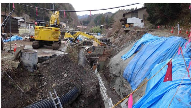
豪雨による大水で護岸が長い距離にわたって崩落した現場の護岸工事が進んでいます。
